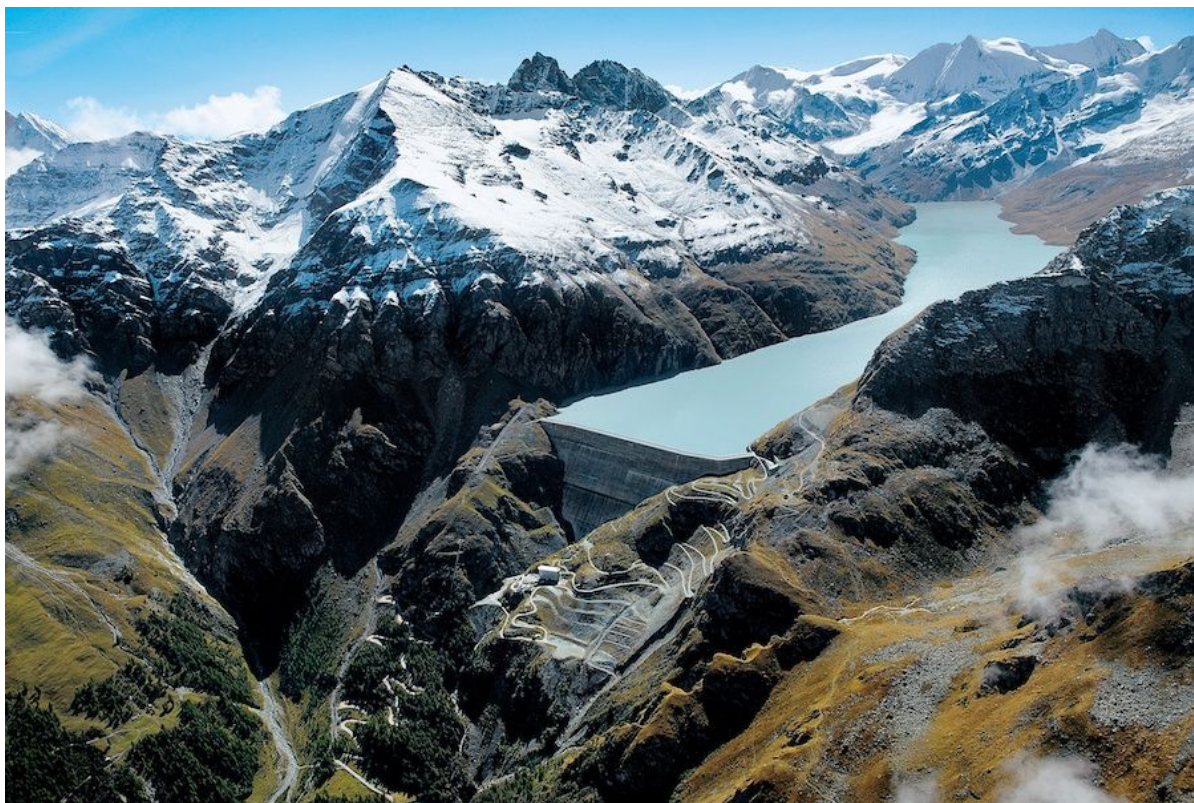
Le barrage de Grande-Dixence dans les Alpes suisses et le lac artificiel des Dix, qui s'étend sur 5 km © Grande-Dixence SA
