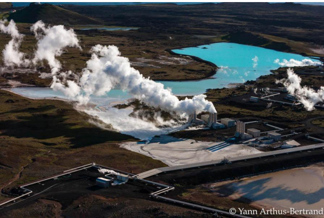
Centrale géothermique près du phare de Reykjanesta, Islande
